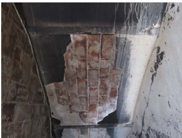
Poškozená konstrukce stávajícího SDK podhledu nad 3.NP
